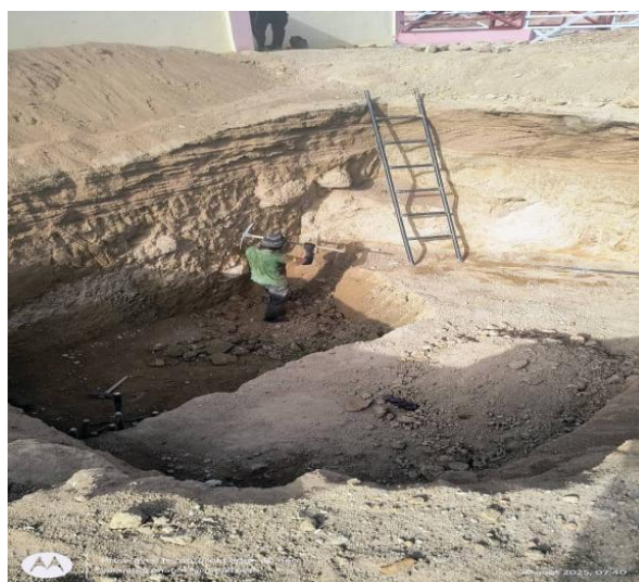
Fouille au niveau de la grande fosse
