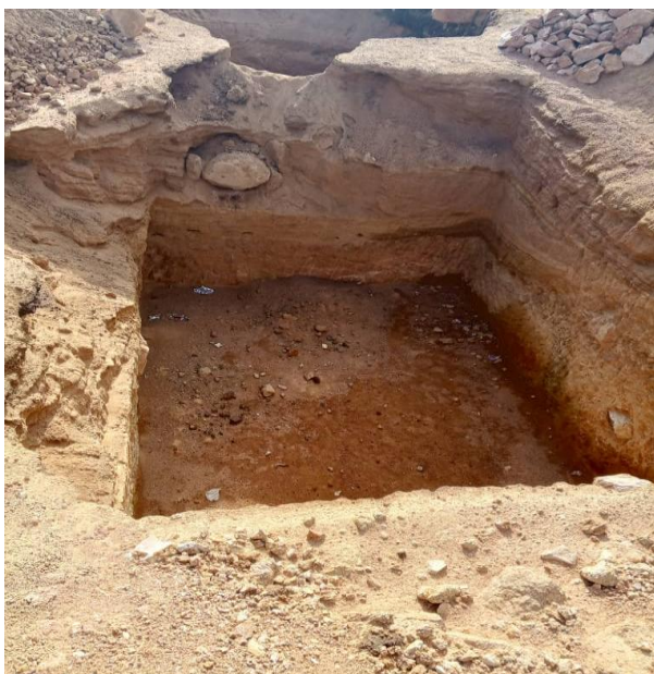
Fouille de la fosse septique
