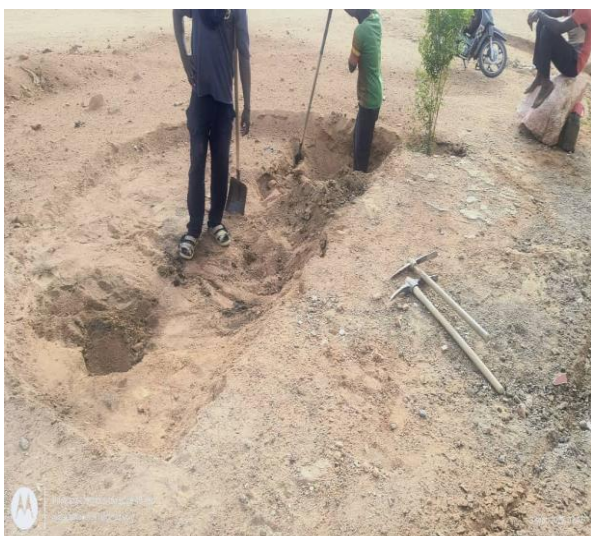
Début de fouille puisard
