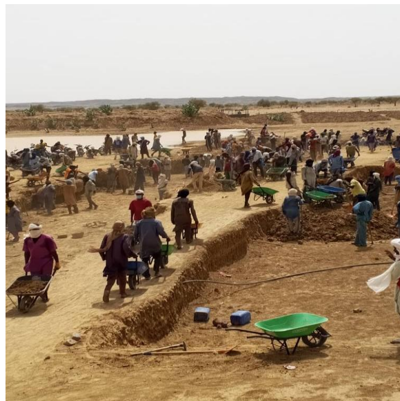
Travaux de surcreusement
