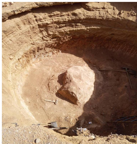
Fouille du puisard
